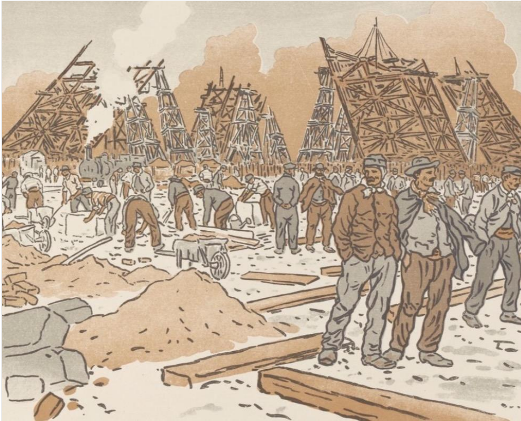
FIG. 3. Building the great piers on the Champ-de-Mars. From H. Rivière, Les trente-six vues de la Tour Eiffel (1902).
